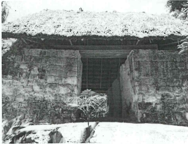
Foto 6. Pasillo central, Edificio D, Nakum
