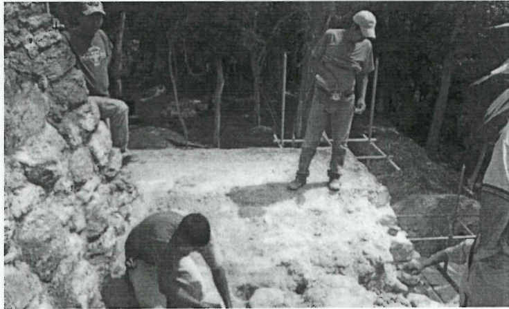
Foto 8. Trabajos en el Edificio 137, Acrópolis Norte
